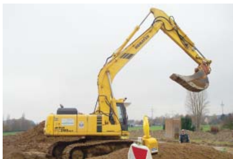
Die Erdarbeiten am Alten Dortmunder Weg haben bereits begonnen.
