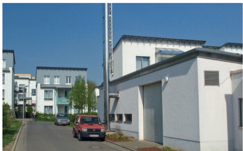
Die Technik im Blockheizkraftwerk (BHKW) Am Zimmermanns Wäldchen wird erneuert und durch eine Luft-Wärmepumpe erweitert.
