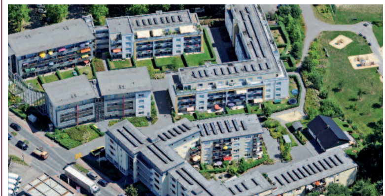
Stromerzeugung auf den Dächern des Wohnquartiers Schützenstraße.
