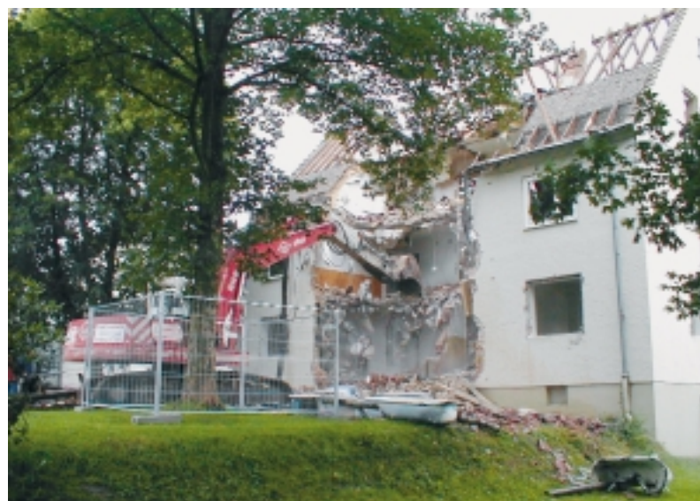
Nach dem Abriss kann nun mit dem Neubau begonnen werden.
