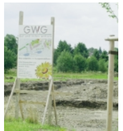
Baubeginn Am Ziegelofen.
