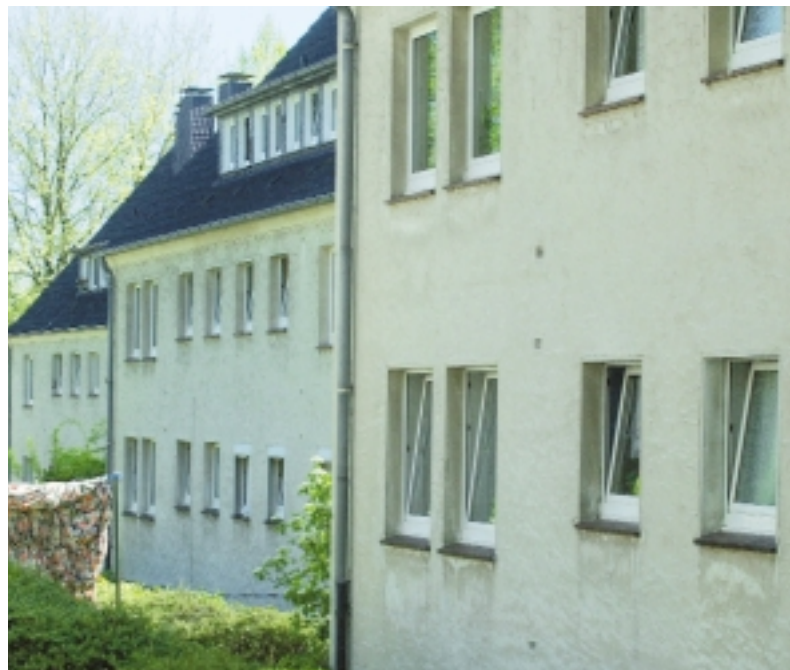
Das Wohngebiet Im Spieckebruch / Bergische Straße / Alter Dortmunder Weg.
