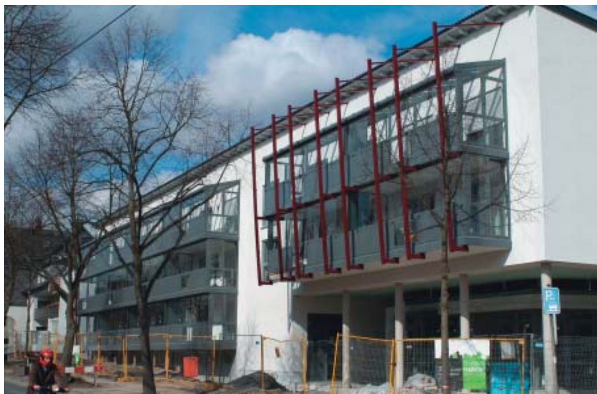
Eine städtebaulich und architektonisch bemerkenswerte Fassade erhält unser Neubau am Holzener Weg 30. Die vom Architekturbüro Künkler entworfene rote Stahlkonstruktion wird auch am hinteren Gebäudeteil montiert.
