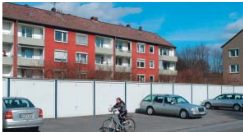
90 Wohnungen werden an der Märkischen Straße modernisiert.
