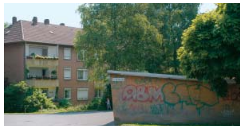
An Stelle der alten Garagen rückt ein Neubau mit 33 Wohnungen.
