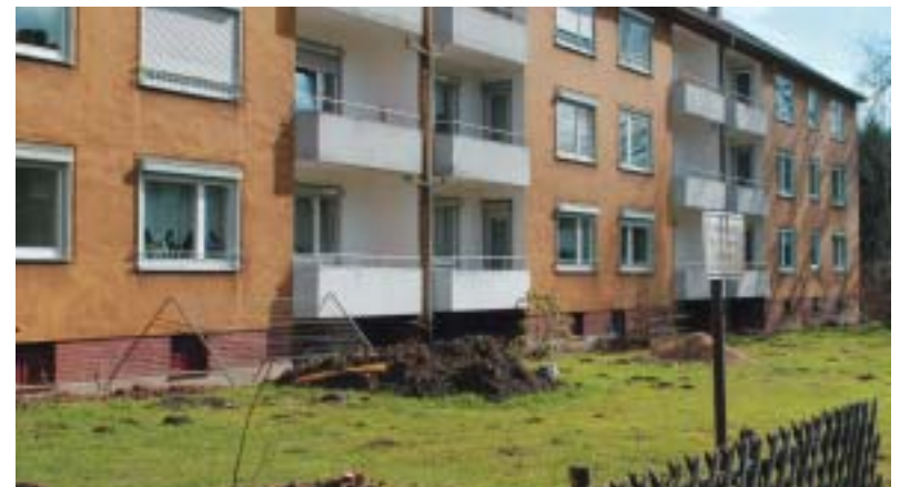
Die Vollmodernisierung an der Schützenstraße beginnt im Frühjahr.
