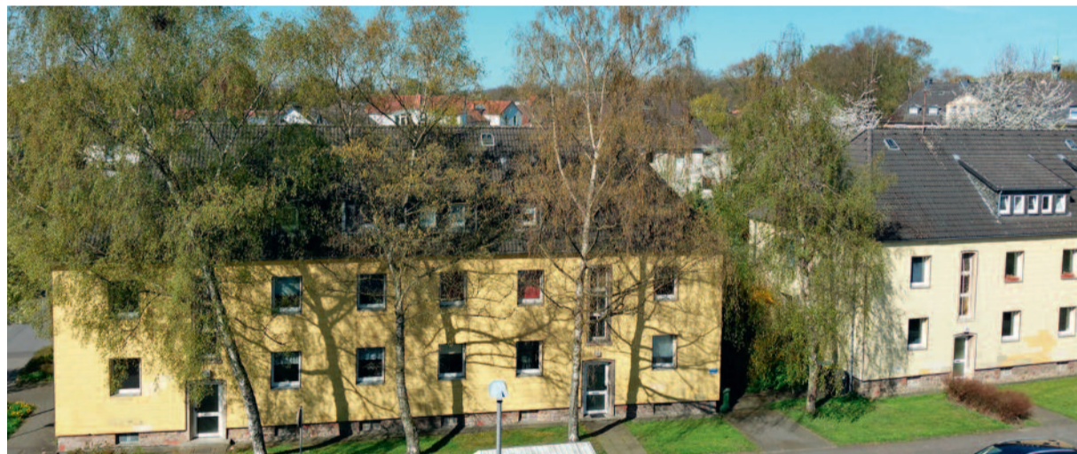
Die Häuser an der Lohbachstraße werden bald der neuen Klimaschutzsiedlung weichen.
