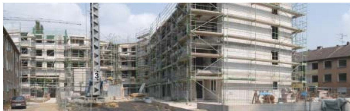
Das Werner-Steinem-Zentrum ist der erste Bauabschnitt an der Schützenstraße, die Häuser am linken Bildrand werden im zweiten Schritt modernisiert. Die Häuser am rechten Bildrand sind bereits leer und werden abgerissen, hier entstehen im dritten und vierten Bauabschnitt neue Wohnungen.
