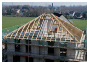
Rohbau 2007 Stadthausvilla mit Zeltdach
