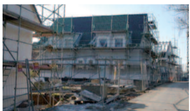
Rohbau Sachsenweg 2007 2. Bauabschnitt
