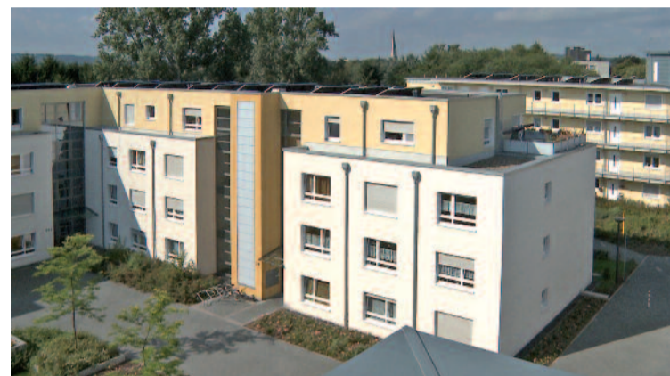
Auf den Dächern der Neubauten an der Schützenstraße erzeugen dezent montierte Fotovoltaik-Kollektoren unablässig Strom, der ins Netz der Stadtwerke eingespeist wird.
