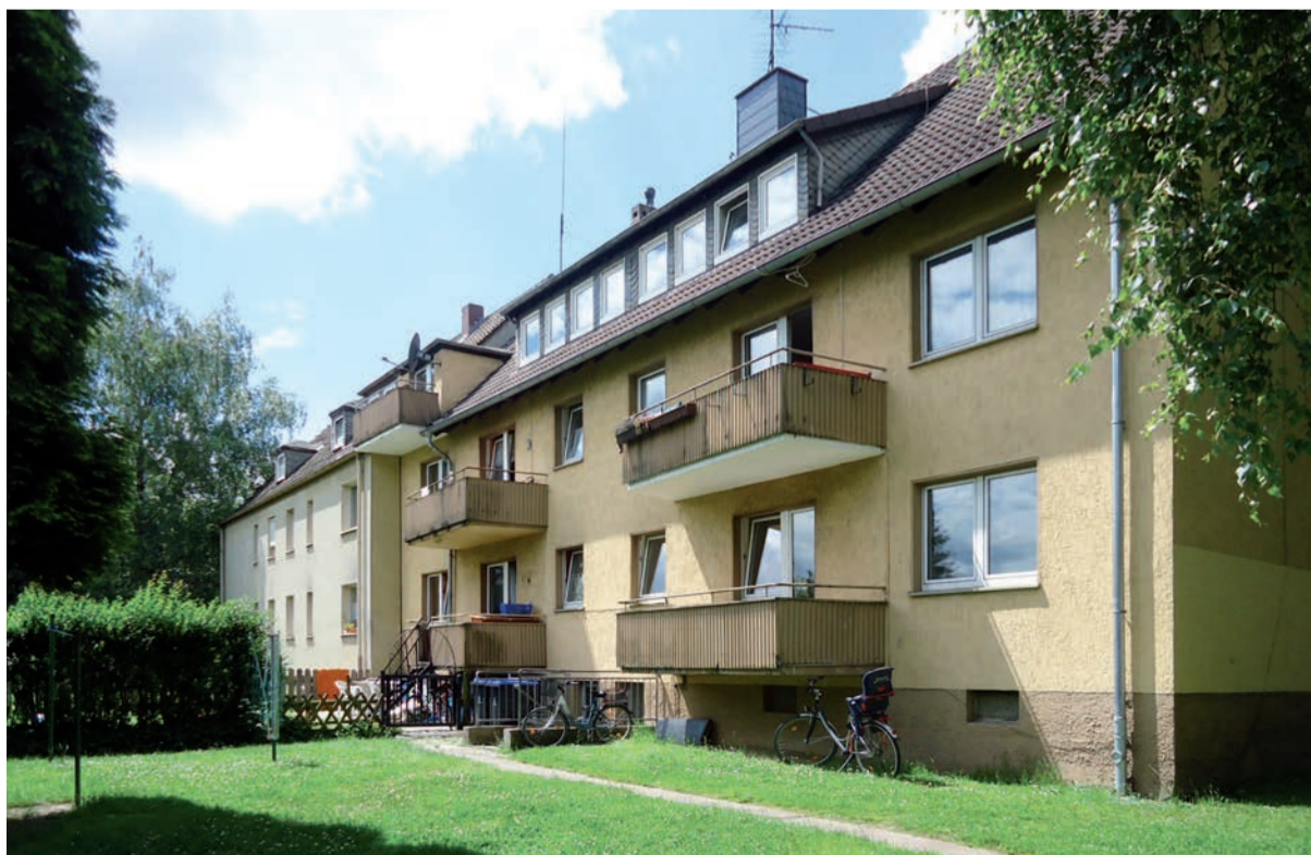
Die alten Balkone werden zugunsten großzügiger neuer Balkone abgerissen.
