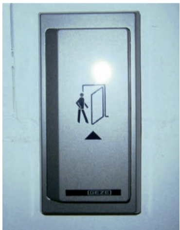
Mit einfachem Druck auf diese Taste öffnen sich jetzt die Verbindungstüren in den Kellern und zur Tiefgarage in der Schützenstraße
