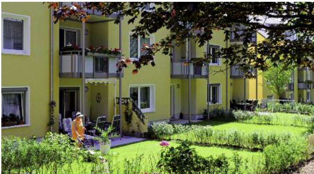
Nach der Modernisierung hat die Wohnqualität an der Virchowstraße enorm zugenommen.
