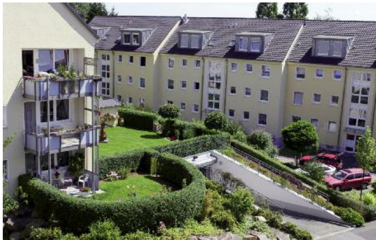
Auf der Tiefgarage befinden sich die Mietergärten.
