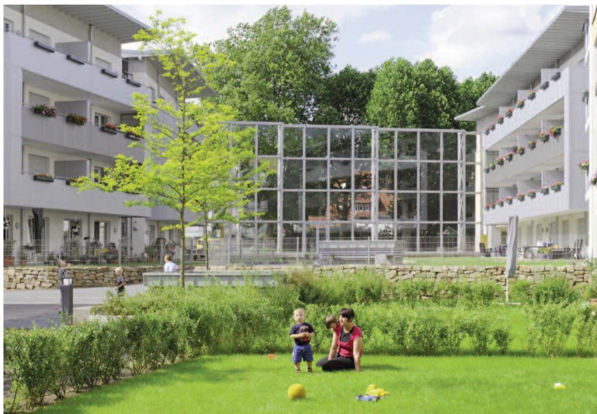
Durch die enorme Schalldämmung der Glaswand ist die Wohnqualität jetzt ganz hervorragend.
