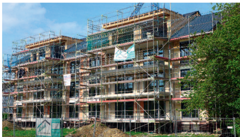
Die Häuser Am Bruch 20 und 22 werden zurzeit modernisiert.
