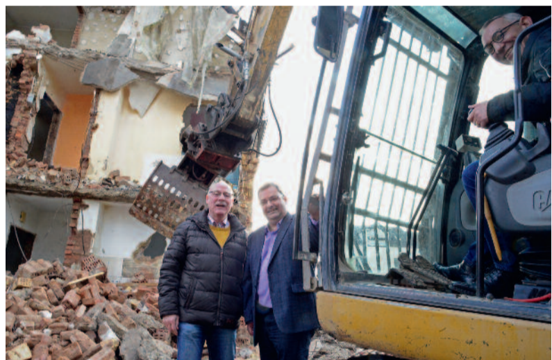
Bürgermeister Böckelühr sah sich den Abriss aus der Baggerperspektive an. Jürgen Tekhaus und Ralf Grobe erläuterten dem Stadtoberhaupt die Pläne für die neuen Wohnungen.
