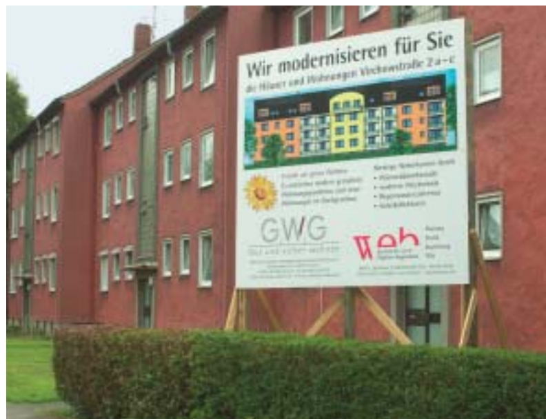
Am 19. August beginnen die Bauarbeiten an der Virchowstraße 2 a-c.
