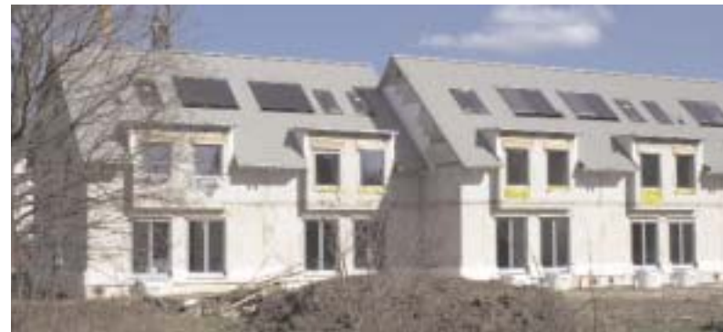
Die letzten elf Häuser sind bereits im Rohbau erstellt.
