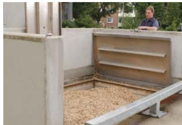
*Die Holzhackschnitzel werden in Vorratsbunkern in der Nähe der Heizanlagen gelagert, das Bild zeigt die Anlage an der Sauerlandstraße.*
