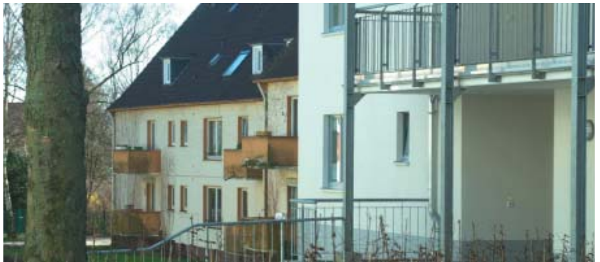
Alt und neu – schon bald GWG-Geschichte. Die Häuser im Hintergrund werden in Kürze abgerissen, im Vordergrund eines der neuen Häuser. Die citynahe Lage gehört zu den Vorzügen.
