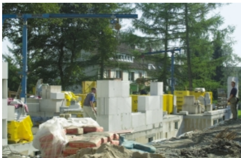
Am Hermann-Löns-Weg wird fleißig gebaut.
