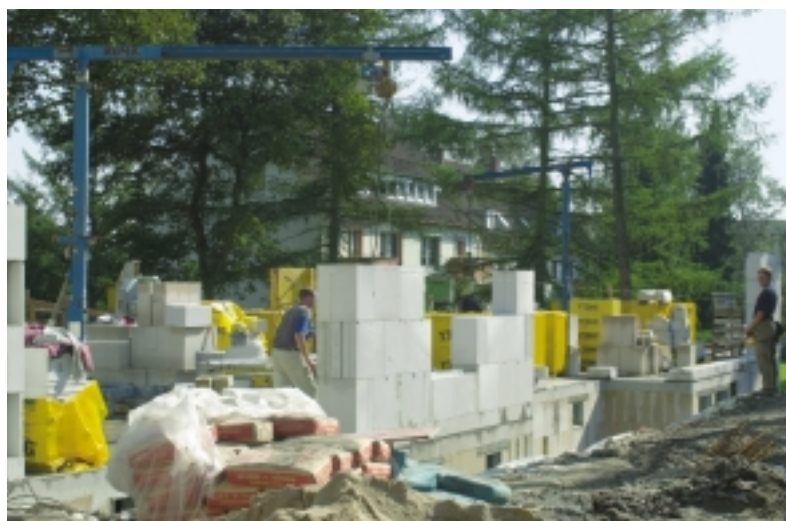
Am Hermann-Löns-Weg wird fleißig gebaut.
